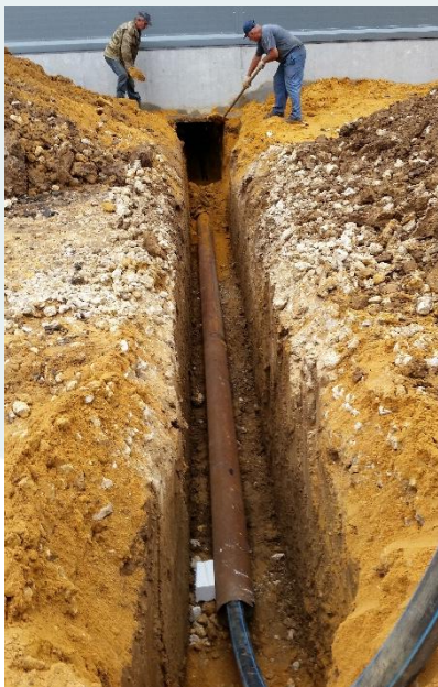
2019г. Устройство сетей водопровода. Земли сельскохозяйственного назначения АО «АПО «Аврора» Липецкой области
