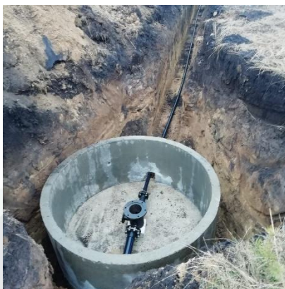
2019г. Устройство сетей водопровода. Водоснабжение жилой малоэтажной застройки с земельными участками в районе переулка Бодрый с. Желтые Пески г. Липецка»
